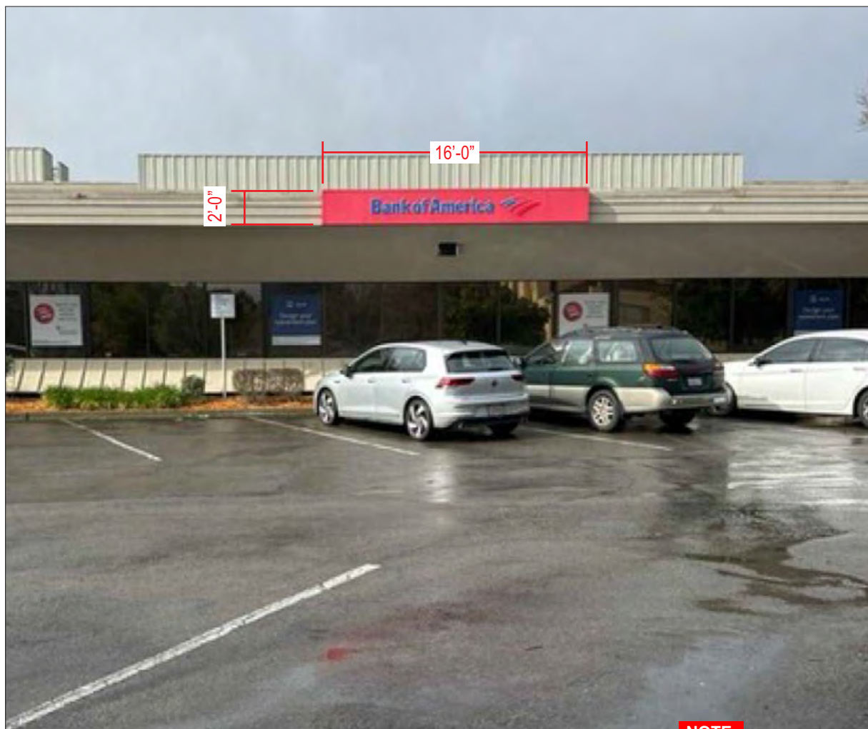
PHOTO SURVEY OF EXISTING Scale: 1/8" = 1'-0"
